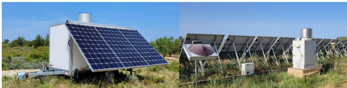
Figure 8 : Dispositifs déployés pour les suivis par radars ornithologiques à la côte. A gauche, l'unité radar mobile et à droite le radar fixe installé au domaine de la Palissade (Camargue).
