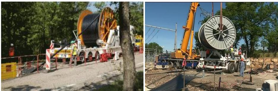
Figure 3: à gauche :pose de câbles à 225 000 volts en région PACA (<https://www.filiere-3e.fr/2013/08/22/silec-cable-installe-la-liaison-souterraine-225-000-volts-boutre-trans-une-premiere-mondiale-au-coeur-de-la-provence/> ), à droite travaux sur le chantier de ligne souterraine à très haute-tension de Saint-Brieuc-Lorient ( <https://france3-regions.francetvinfo.fr/bretagne/ligne-haute-tension-entre-orient-saint-brieuc-inauguree-lundi-1399165.html> ) .
