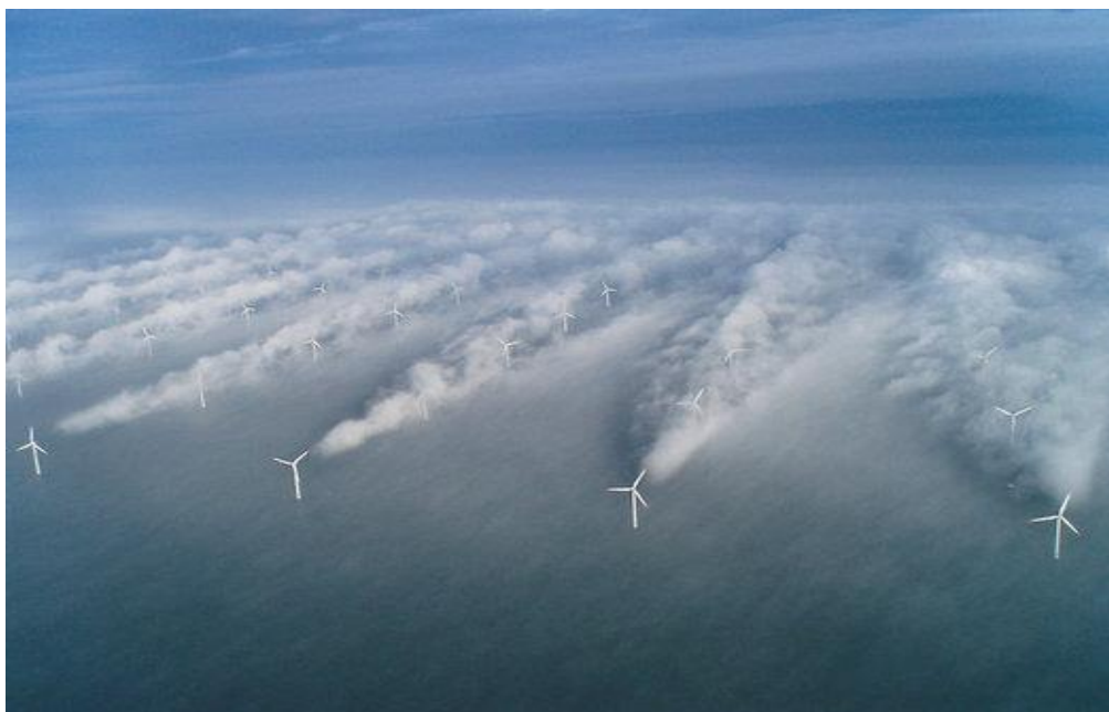
Figure 3 : Centrale éolienne de Horns Rev 1, au Danemark : formation de brouillards, permettant de visualiser les turbulences provoquées par les éoliennes derrière elles. Les éoliennes font chuter brutalement la vitesse du vent derrière elles, ce qui provoque d'importantes variations de pression, ainsi que des traînées et des turbulences sur des km, rendues visibles ici par la formation de brouillards, comme dans le cas de la traînée des avions en altitude. Ces turbulences sont dangereuses pour les oiseaux et les chauves-souris, mais aussi pour les avions et les ULM passant à trop basse altitude (d'où les interdictions de survol et la signalisation par flash) et aussi pour les petites embarcations.
